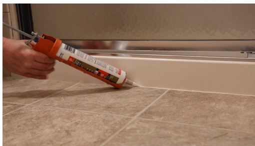
Use silicona en todos los border para crear un sello hermetico.
