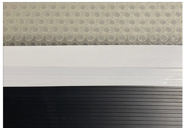
Vista superior - Rampa Reductora instalada con Costura sellada con
